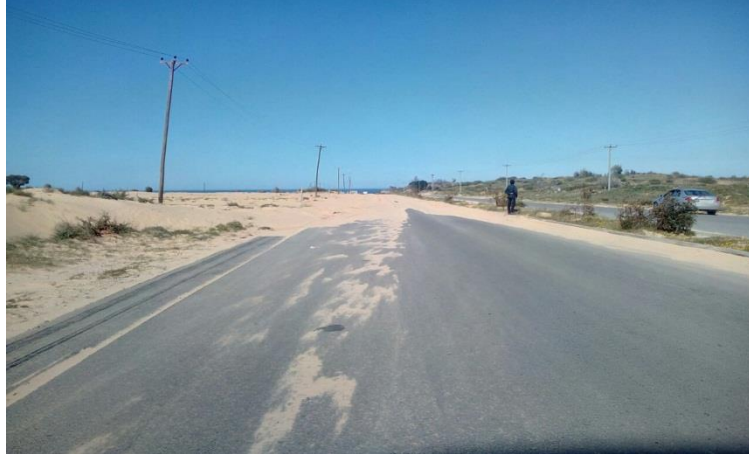
صورة رقم (2) توضح زحف الرمال على الطريق الرابط بين مصيف القره بوللي والقره بوللي المركز بسبب القطع الجائر لأشجار الغابات والتسبب في وجود تصحر شديد بالمنطقة.
